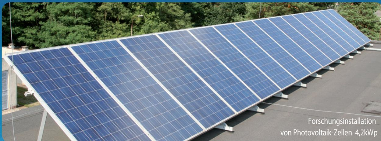
Forschungsinstallation von Photovoltaik-Zellen 4,2kWp
