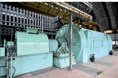
Kurzschlussgenerator 2500 MVA.
