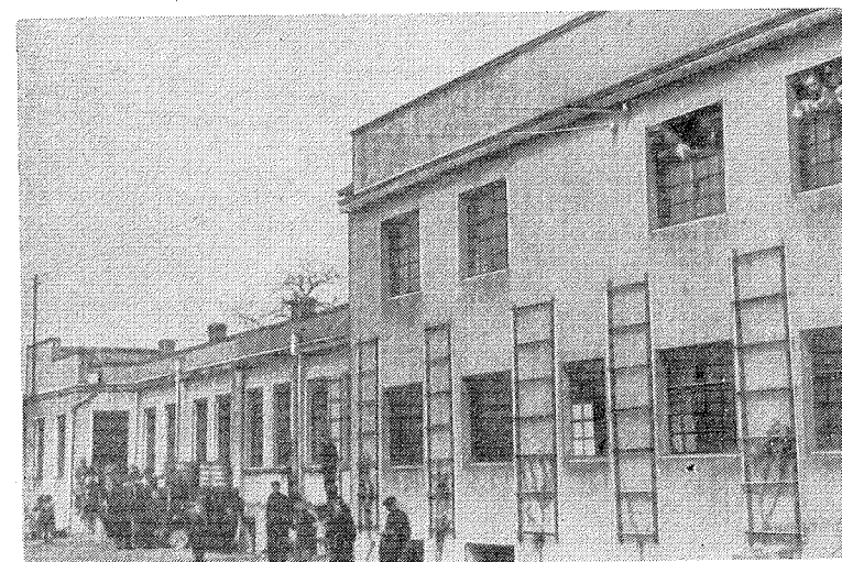
Rys. 4.23. Fabryka Polskich Zakładów Elektrotechnicznych Era we Włochach pod Warszawą
