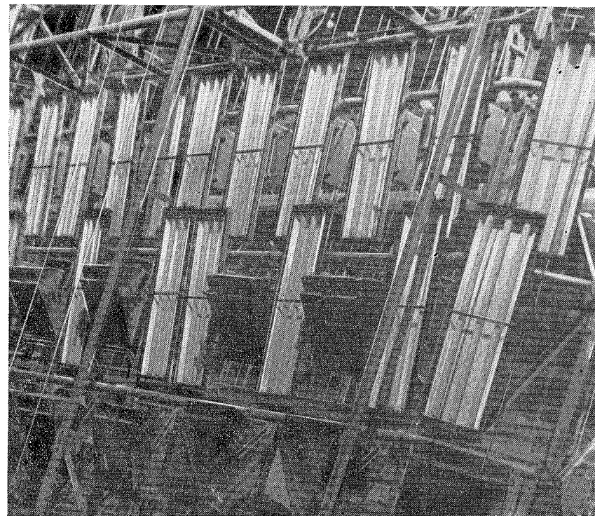
Rys. 8.10. Fragment mostu horyzontowego w Teatrze Wielkim
