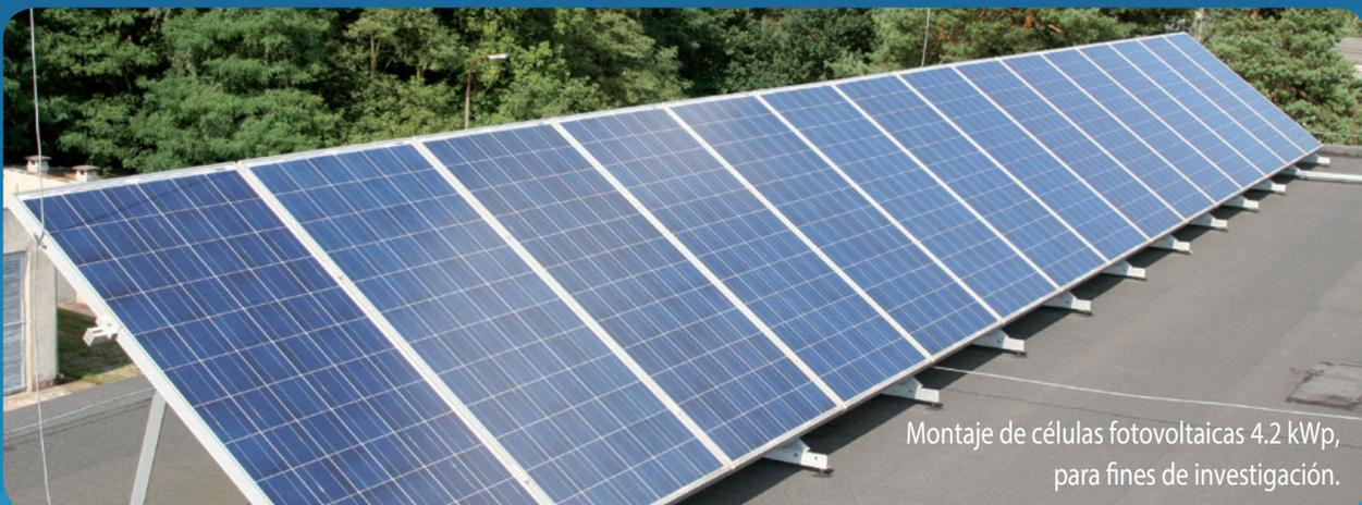
Montaje de células fotovoltaicas 4.2 kWp, para fines de investigación.
