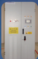
2 МДж, 150 кВт, Суперконденсаторный накопитель электроэнергии большой мощности, для применения на тяговых подстанциях для рекуперативного торможения Email: nte@iel.waw.pl
