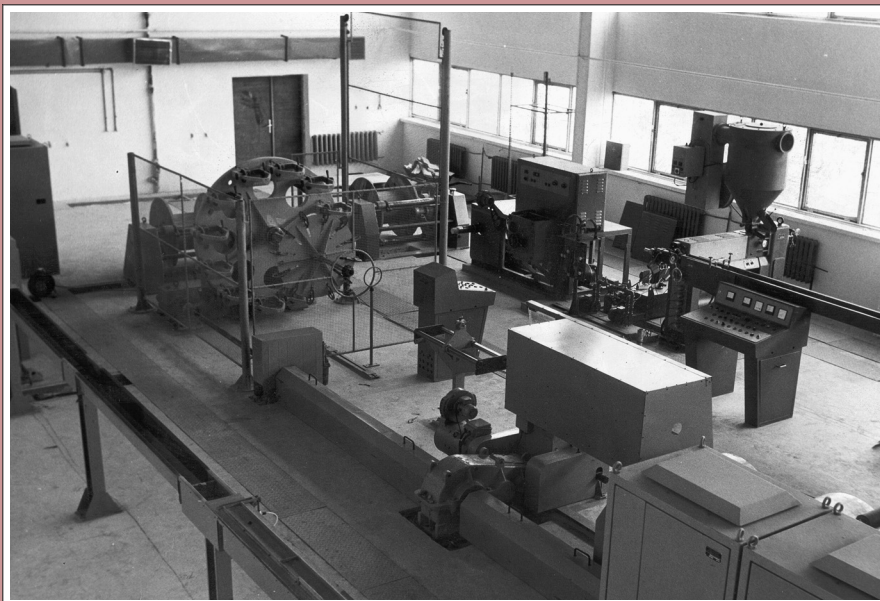
Ryc. 3.15 OTO Lublin – montaż maszyn w hali kablowej
