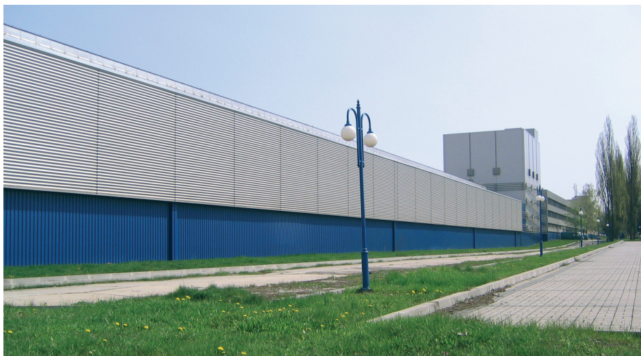
Ryc. 4.1.14 TELE-FONIKA Kable S.A. Zakład Kraków
