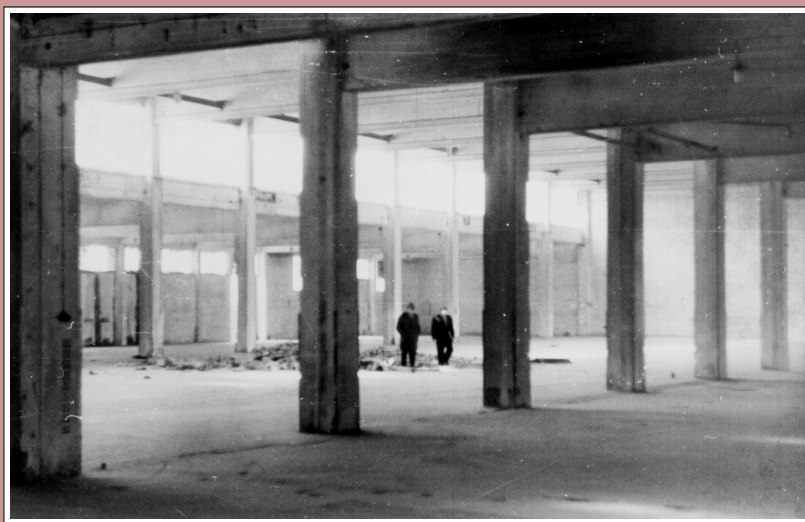
Ryc. 4.1.45 Hala produkcyjna w odbudowie
