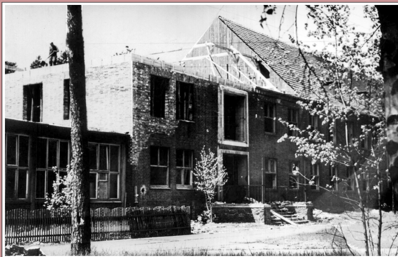
Ryc. 4.1.44 Budynek biurowy przed odbudową
