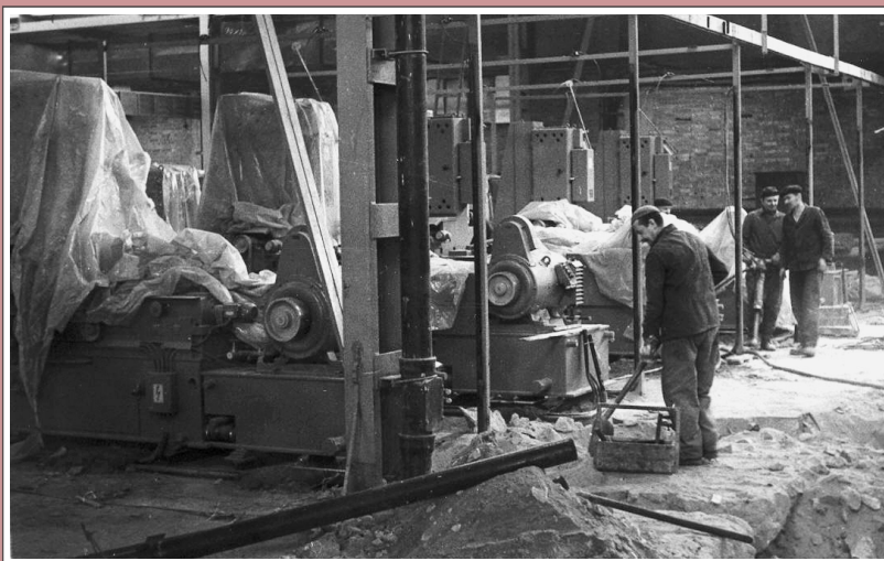
Ryc. 4.1.46 Hala średnociągów w odbudowie
