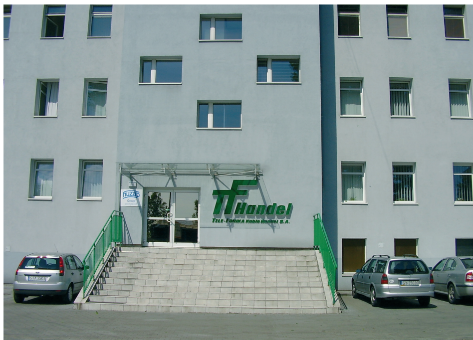
4.1.54 TELE-FONIKA Handel Budynek główny
