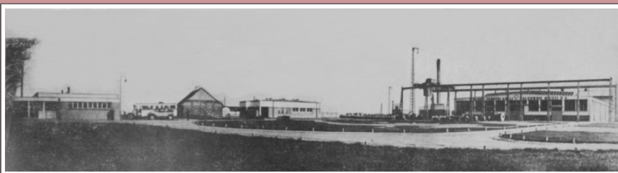
Ryc. 1.2 Panorama Fabryki Kabli w Ożarowie Mazowieckim – 1936 rok [5]
