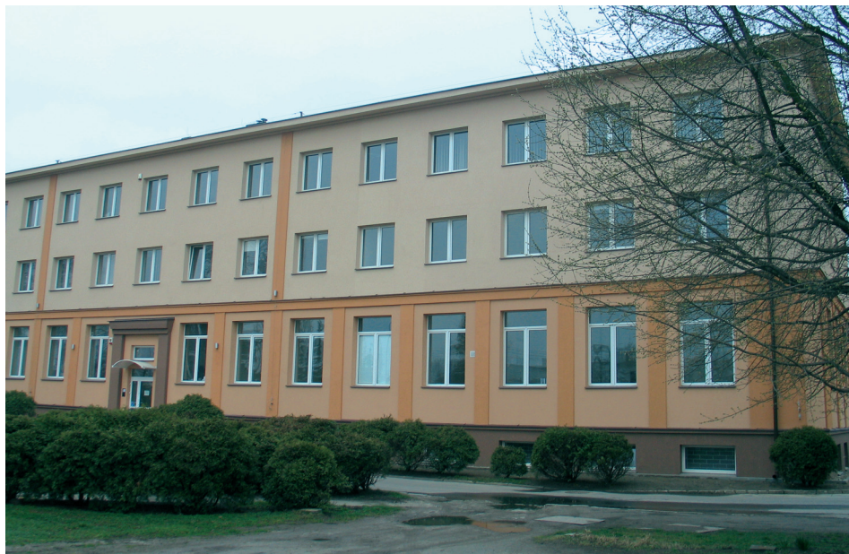
Ryc. 4.1.75 Budynek główny CBKK oddany do użytku w 1956 r w Ożarowie Mazowieckim
