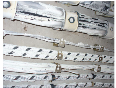
Widok kabli prowadzonych po suficie po próbie ogniowej
