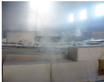
Widok stropu komory ogniowej
