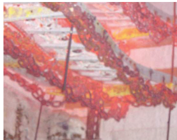
Widok tras kablowych podczas próby ogniowej
