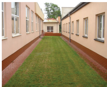
Ryc. 4.13.4 Hale produkcyjne przewodów elektroinstalacyjnych
