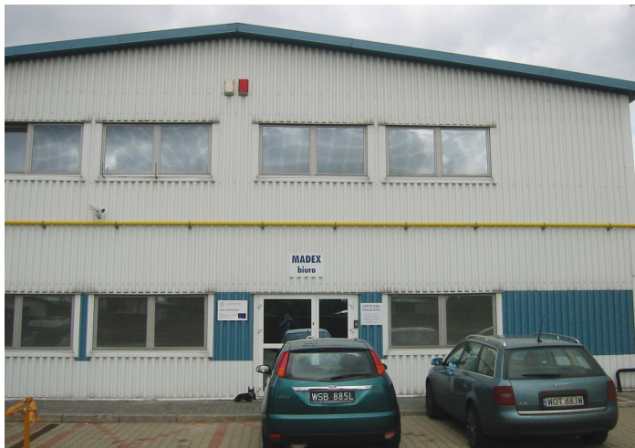
Ryc. 4.21.1 FK MADEX – wejście do budynku administracyjnego
