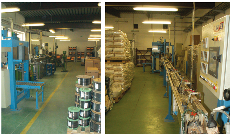
Ryc. 4.22.2 Linie LW1 (z lewej) i LW2 (z prawej) po modernizacji w latach 2004–2005, Zakład Jaworzno
