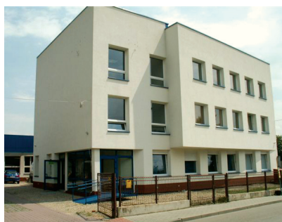
Ryc. 4.22.4 Budynek administracyjno-socjalny Zakładu Jaworzno w końcowej fazie budowy – 2005 r.
