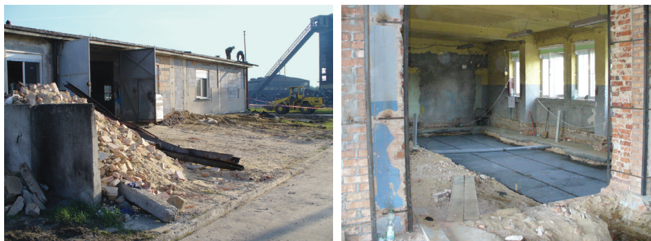
Ryc. 4.22.5 Początek modernizacji obiektów w Skawinie – 2005 r.
