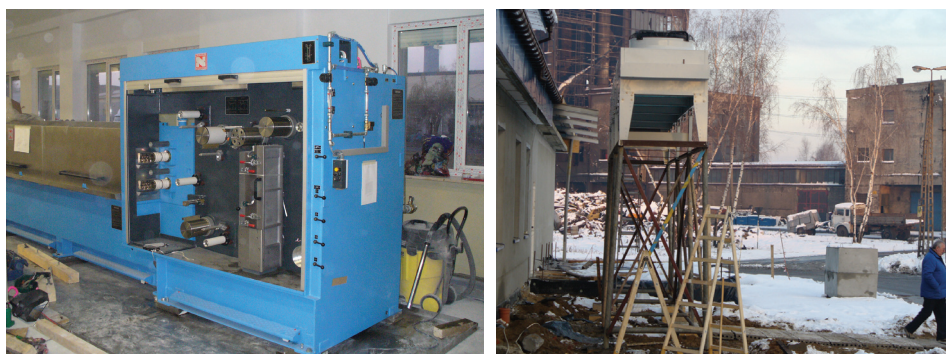
Ryc. 4.22.6 Początek montażu linii MMH w trakcie prac wykończeniowych hali i montaż chłodni wentylatorowej na zastępczej konstrukcji – przed budową (w II kw.2006r.) budynku technicznego chłodni wraz ze stacją transformatorową – widok z IV kw. 2005 r. W głębi budynki dawnej huty aluminium, rozebrane w 2006 r.
